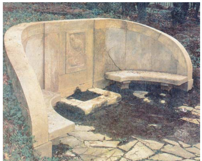
So sah das Pflingstbörnchen vor der Renovierung aus
